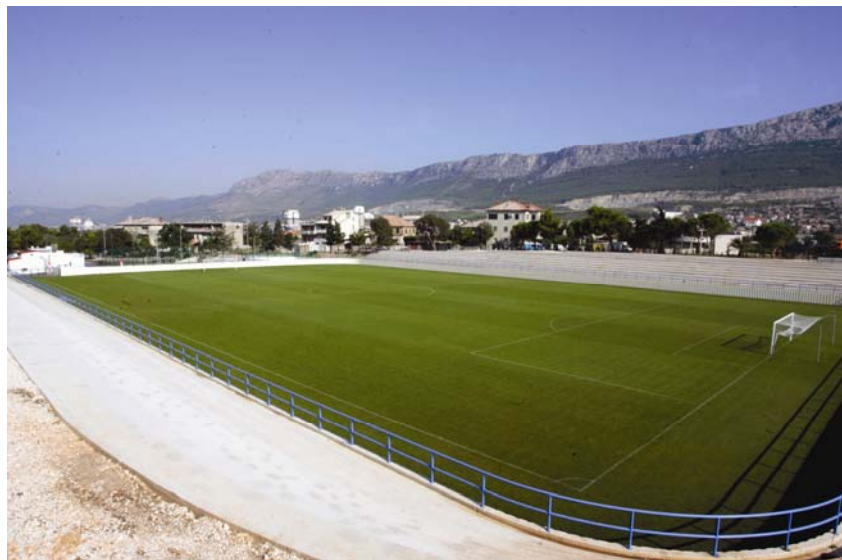
Ispod površine stadiona u Vranjicu odloženi su dijelovi azbestnog otpada
