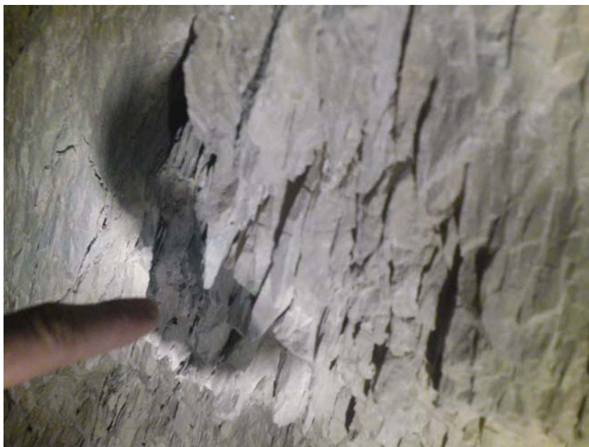
Listanje stijena zbog velikih naprezanja
