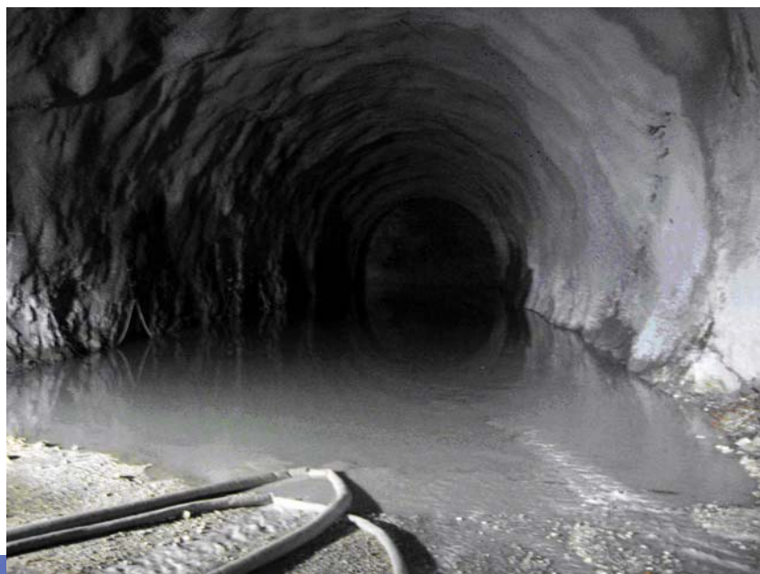
Voda prikupljena ispred čela proboja
