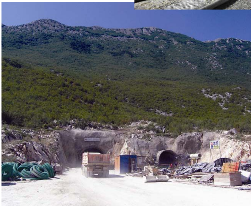
Radovi na sjevernom portalu tunela Sv. Ilija
