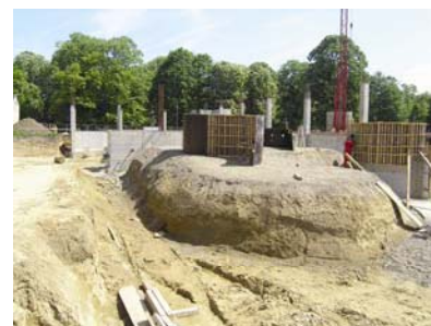
Dio radova snimljen tijekom posjeta gradilištu
