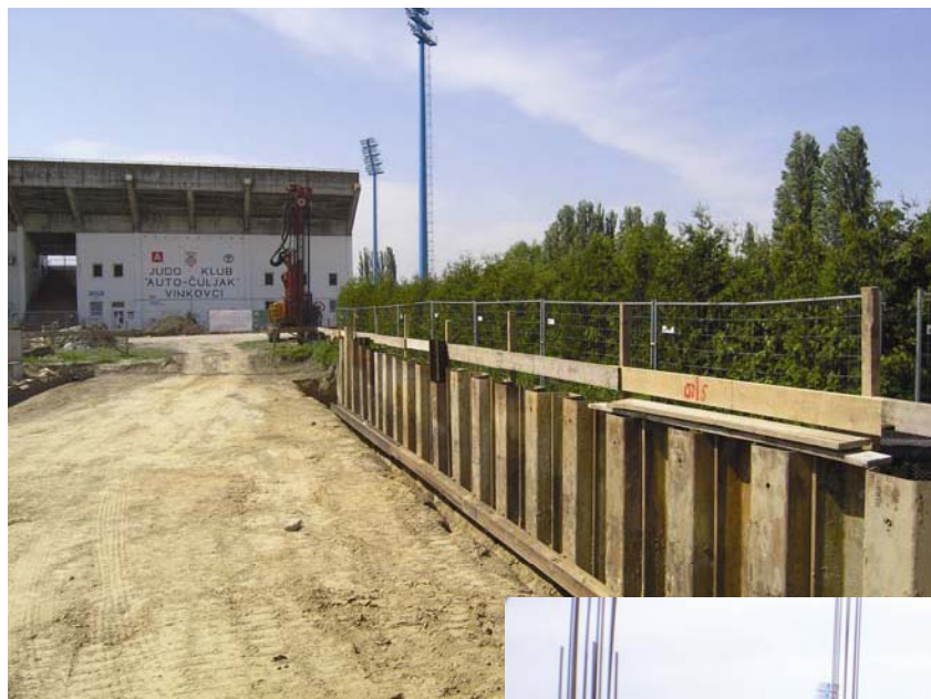
Zaštita građevinske jame čeličnim žmurjem
