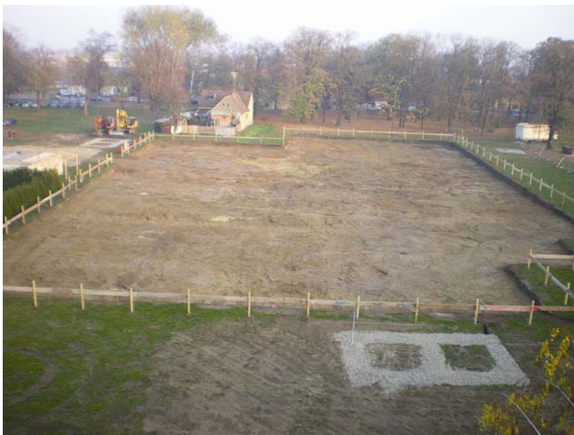
Uređena lokacija prije početka radova
