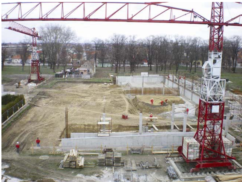
Pogled na gradilište s tribine nogometnog stadiona
