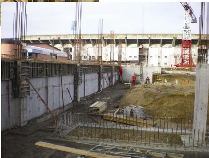
Betonski radovi u početku građenja
