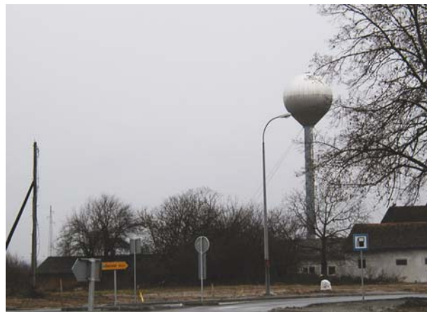
Slika 7. Vodotoranj u Velikim Zdencima
