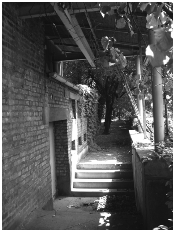
Slika 9. Ulazni trijem vodocrpilišta
