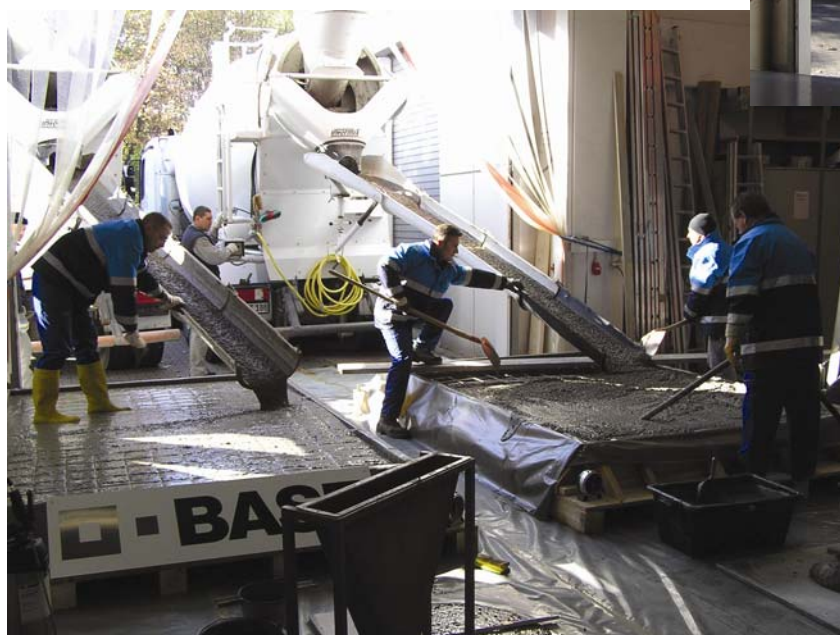
Usporedno betoniranje betonom s RheoMATRIX -om i uobičajenim betonom
