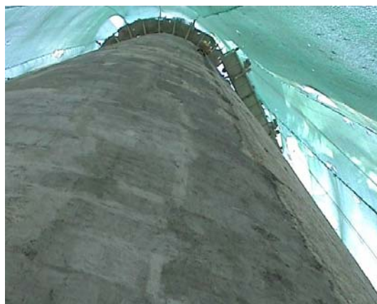
Slika 4. Izvedena sanacija betonske površine s mortom s dodatkom polimera
