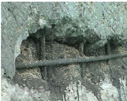
Slika 2. Izvođenje antikorozijske zaštite armature i nanošenje kremenog pijeska za poboljšanje adhezije sanacijskim mortom
