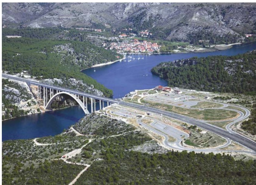
PUO Krka na autocesti Zagreb - Split snimljen iz zraka
