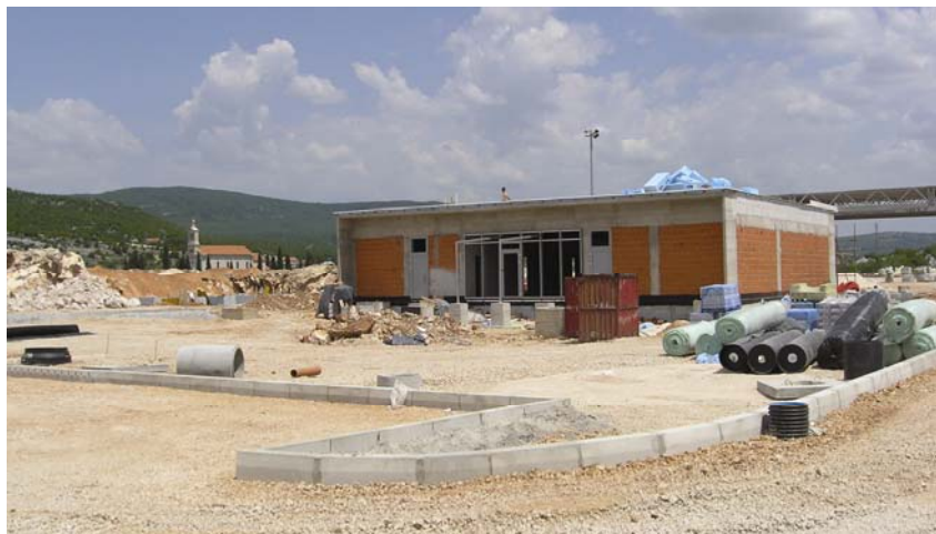
Gradilište PUO-a Mosor sjever
