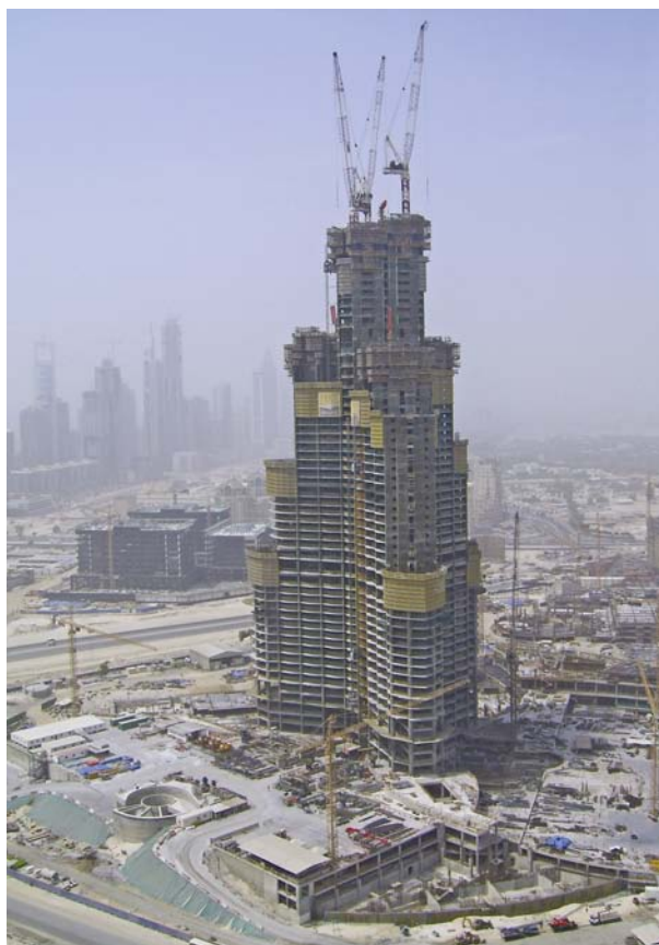
Trenutačno stanje na gradilištu
