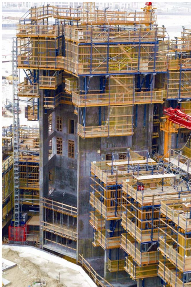
Pogled na oplatu srednje jezgre i zidova krila
