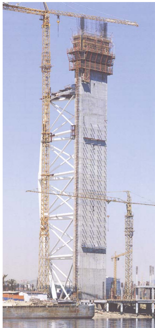
Primjer gradnje samopodiznom oplatom
