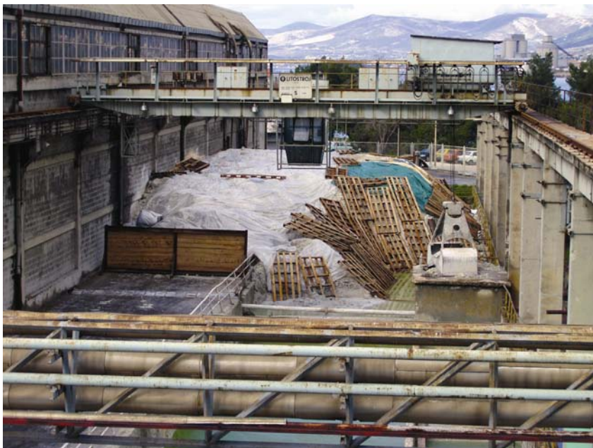
Razbacani materijal u dvorištu tvornice
