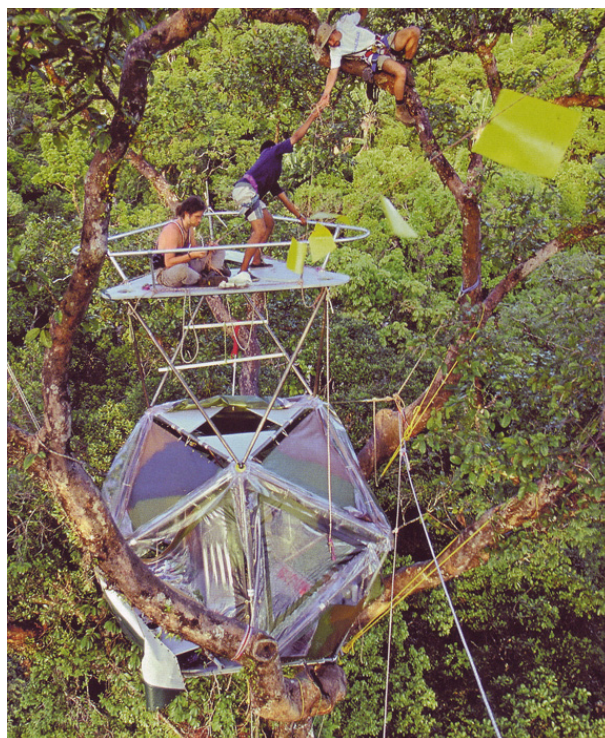
Slika 10. Pomične stanice omogućuju gradnje na teško dostupnim mjestima
