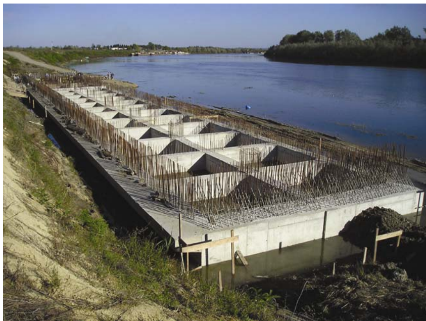
Temeljna armiranobetonska roštiljna konstrukcija
