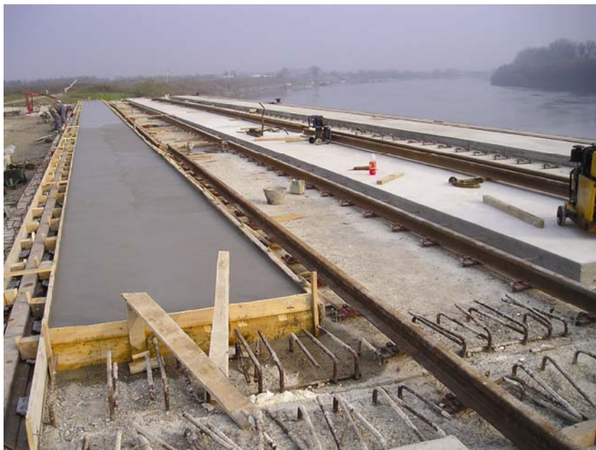
Završni radovi na gradnji prvoga veza
