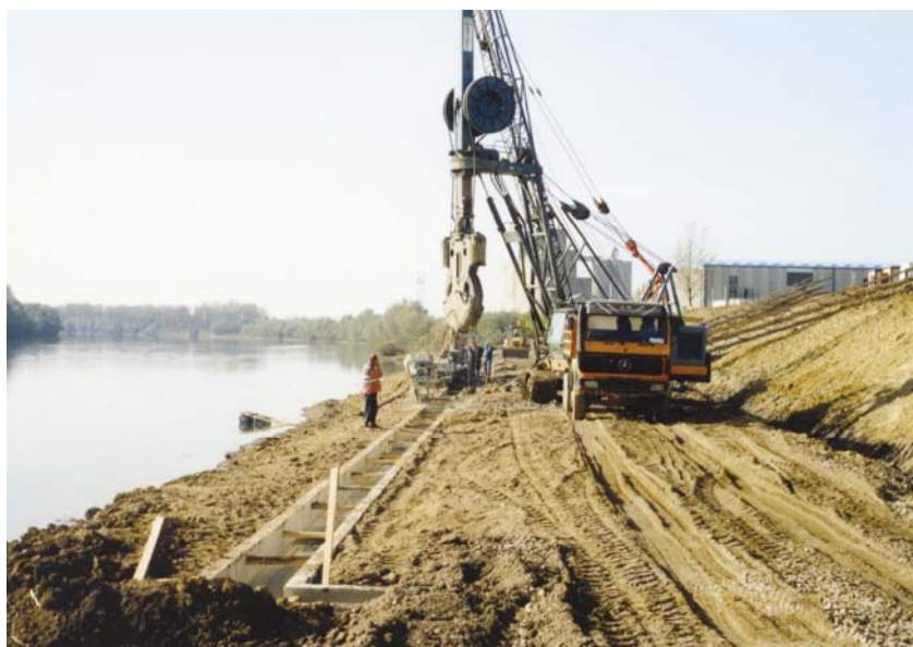
Izvedba armiranobetske dijafragme
