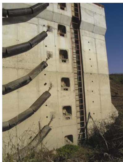
Detalji obalne opreme
