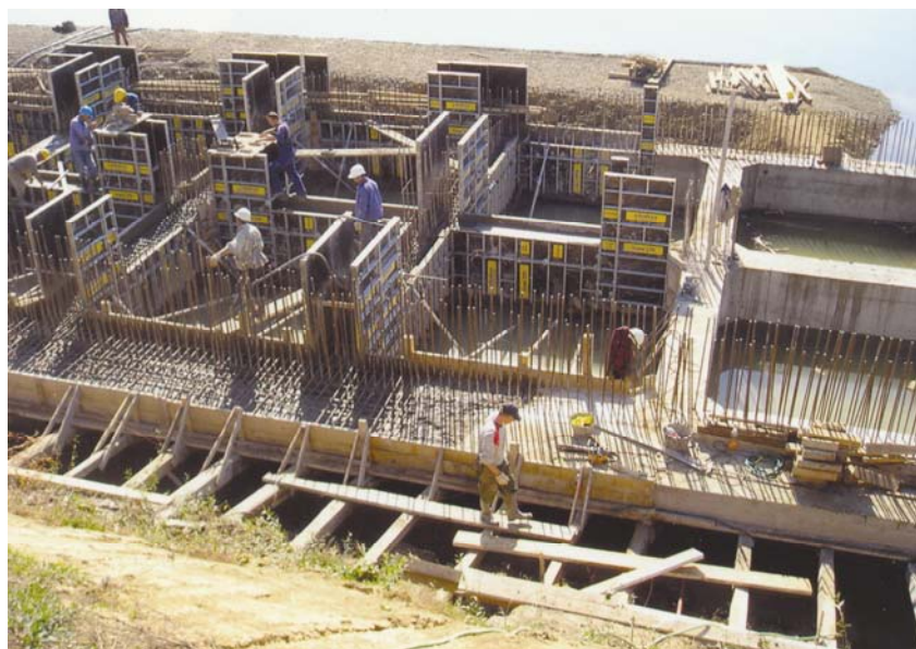
Početak podizanja vertikalne obale
