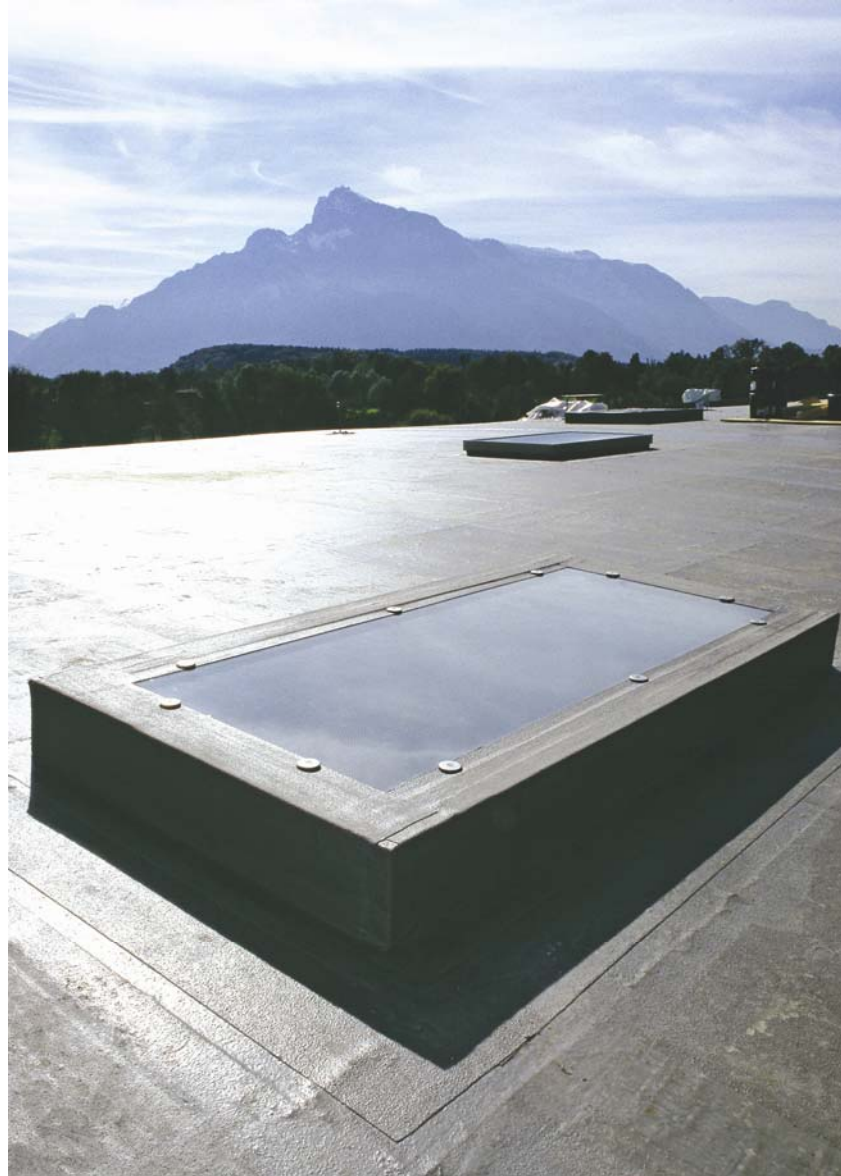
Detalj nadsvjetla na neprohodnome ravnom krovu
