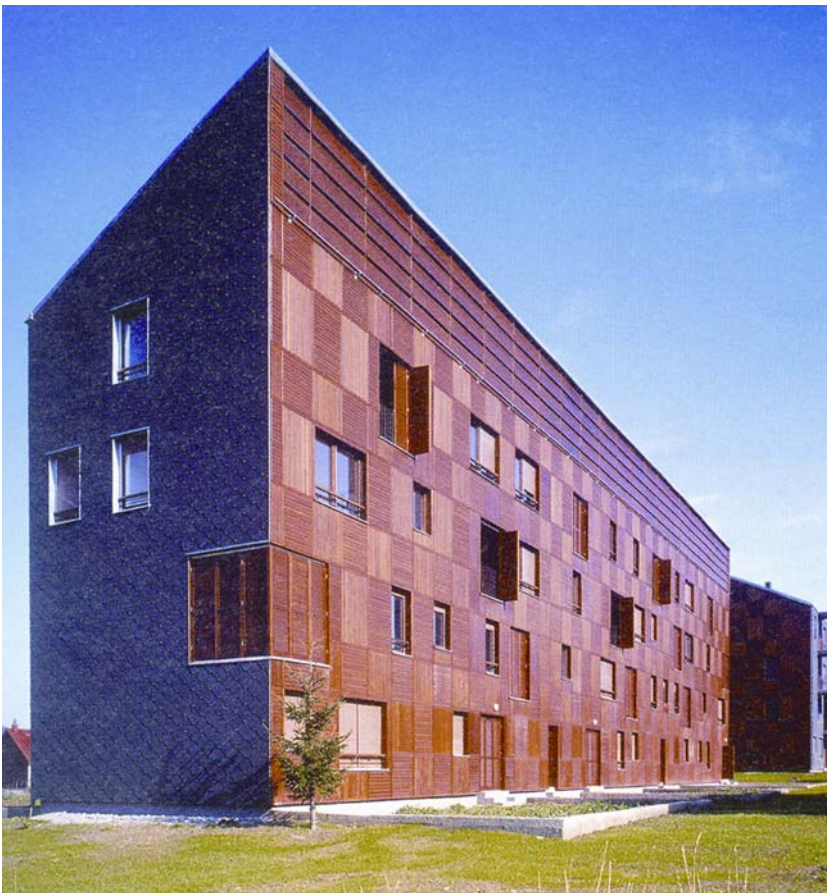
Višestambena zgrada iz programa POS-a u Delnicama, arhitekti Vladimir Kasun i Ivica Plavec
