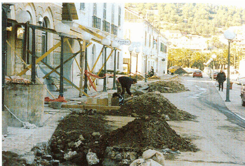
Ugradnja kolektora u središtu Visa
