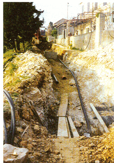
Ugradnja sekundarne kanalizacije
