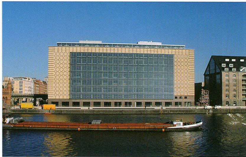
Južno pročelje negdašnje hladnjače
