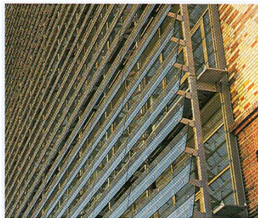
Stakleno pročelje na jugu s ovješanim lamelama za zaštitu od sunca
