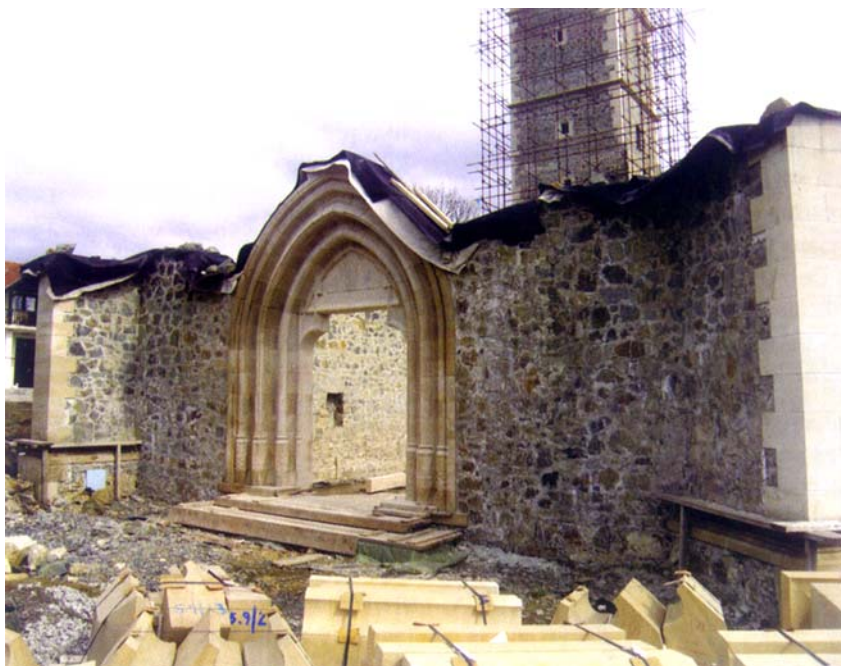
Obnova crkve u Voćinu
