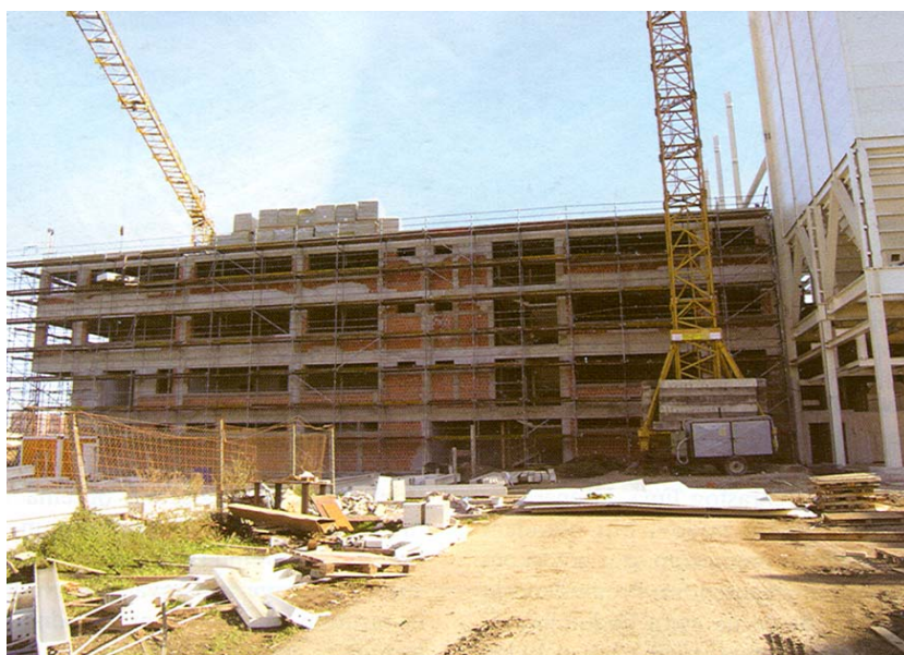
Nova poslovna zgrada u gradnji
