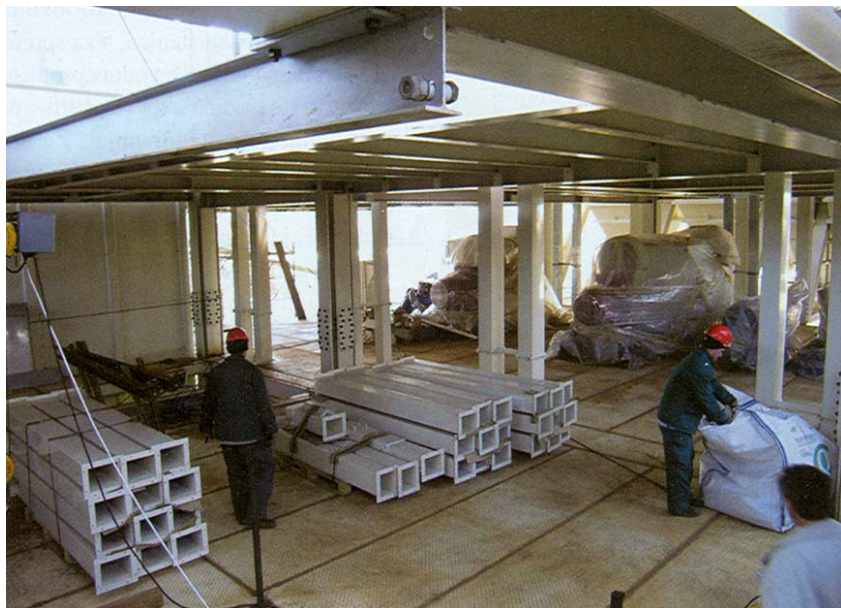
Radovi u prizemlju poslovnog tornja
