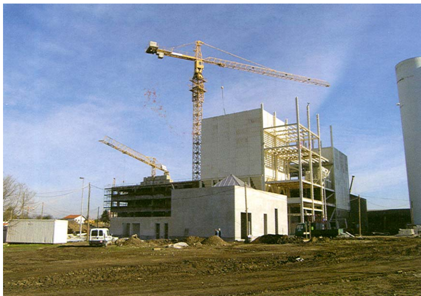
Pogled na gradilište nove tvornice
