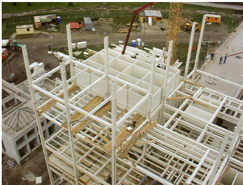
Montaža proizvodnog tornja
