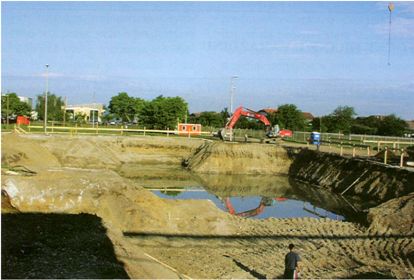
Prvi iskopi na gradilištu tvornice
