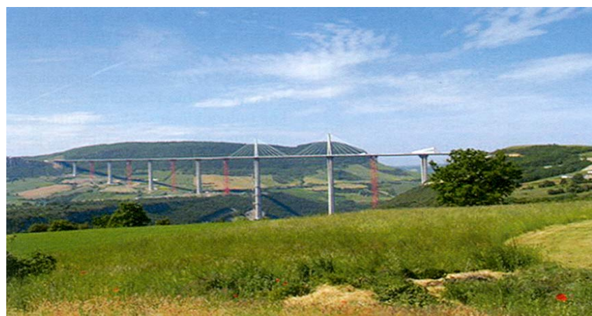
Most Millau uoči podizanja čeličnih nastavaka pilona
