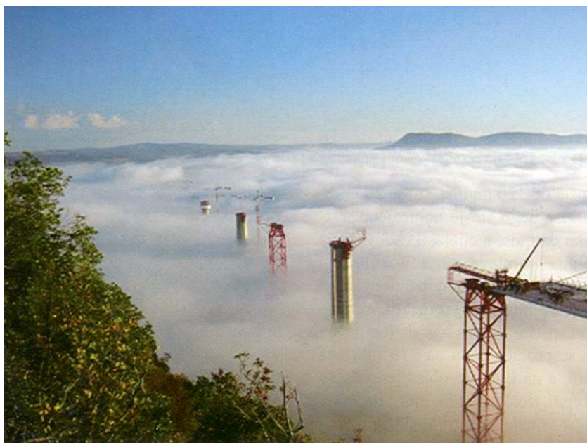
Gradilište u oblacima
