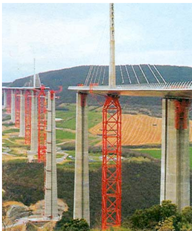
Ugradnja pilona i zatega
