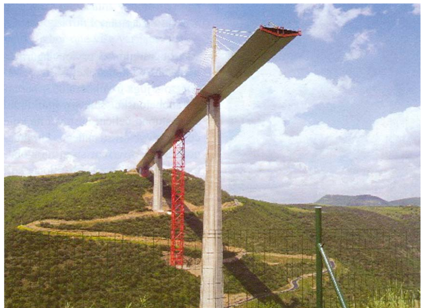
Ugradnja rasponske konstrukcije na sjevernoj strani
