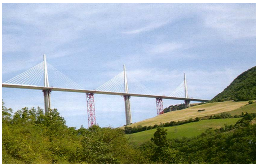
Dio mosta pred završetkom
