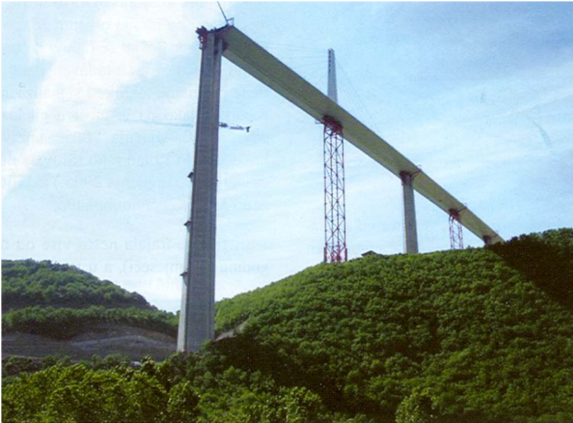
Početak ugradnje rasponske konstrukcije na južnoj strani
