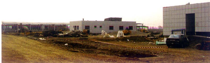
Gradilište upravnih zgrada
