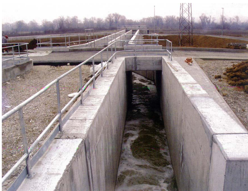
Kanal za ispuštanje pročišćene vode u GOK
