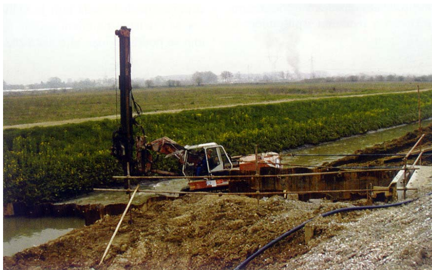
Pregrađivanje glavnog odvodnog kanala (GOK-a)
