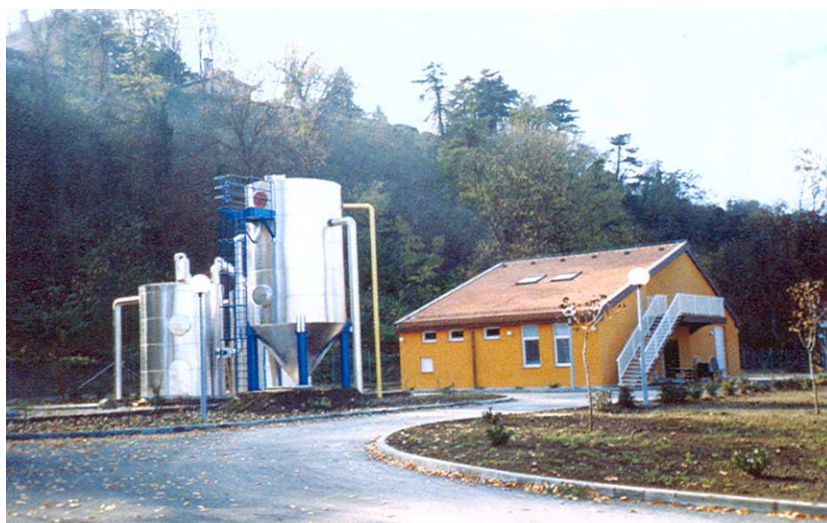
Završena zgrada uz uređaj za pročišćavanje
