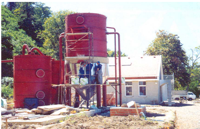
Završni radovi na montaži aeratora-flokulatora
