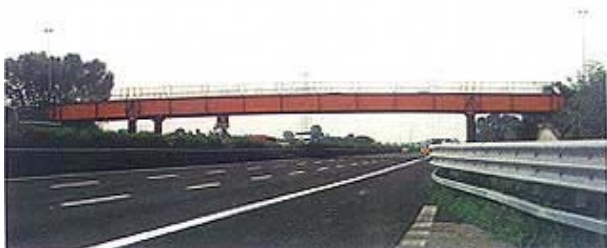
Slika 13. Primjer čeličnog nadvožnjaka preko autoceste
