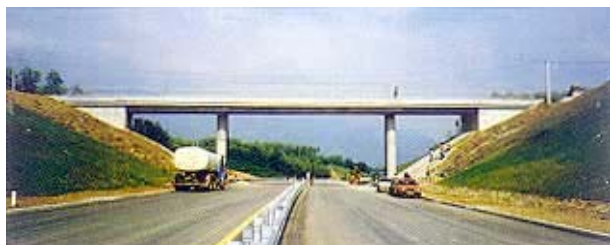
Slika 5. Nadvožnjak sa stupovima u usjeku
