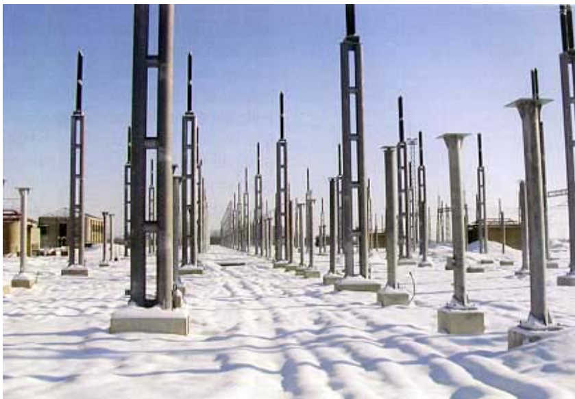
Rasklopno postrojenje od 400 kV za našeg posjeta
