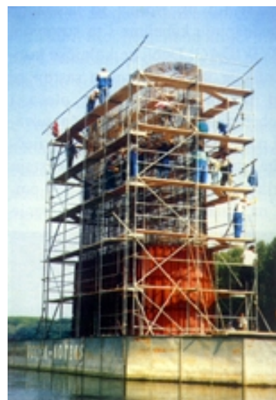
Gradnja stupa u sredini rijeke
