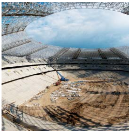
Igralište i tribine Donbas Arene u Donjecku tijekom građenja
